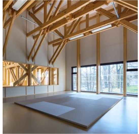
Cette structure en poutre treillis supporte en façade une enveloppe thermique à ossature bois isolée de panneaux de laine de bois et dont la peau extérieure est un bac acier blanc et une résille en Douglas. La toiture terrasse se compose de panneaux CLT épicéa formant support et contreventement, recouverts d'un complexe d'isolation et d'une membrane d'étanchéité PVC.
