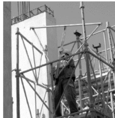
Le Mills Tour est constitué d'éléments préfabriqués modulaires, emboîtables les uns dans les autres et verrouillés sans apport de clavettes ou de boulons.
