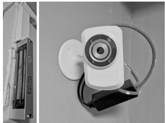
Figure 3 : Ventouse permettant l'ouverture d'une porte (image de gauche) et caméra IP permettant le suivi de la partie par un maître du jeu (image de droite).
