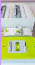
Remplacement – Mise en service de compteur Linky
