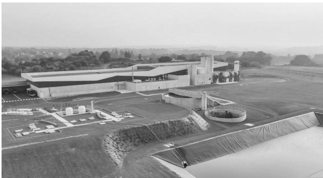
Usine de production d'eau potable de l'agglomération de Saint-Brieuc
