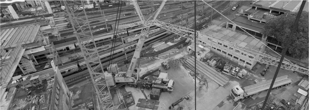
La pose des poutres est réalisée avec une grue mobile dont les caractéristiques sont définies dans le document technique DT13. La masse des poutres de la travée 4 est évaluée à 18 tonnes qu'il faut majorer de 10 % par sécurité. Des plaques de répartition des charges de 4 m x 3 m doivent être mises en place sous chacun des quatre stabilisateurs de la grue mobile.
