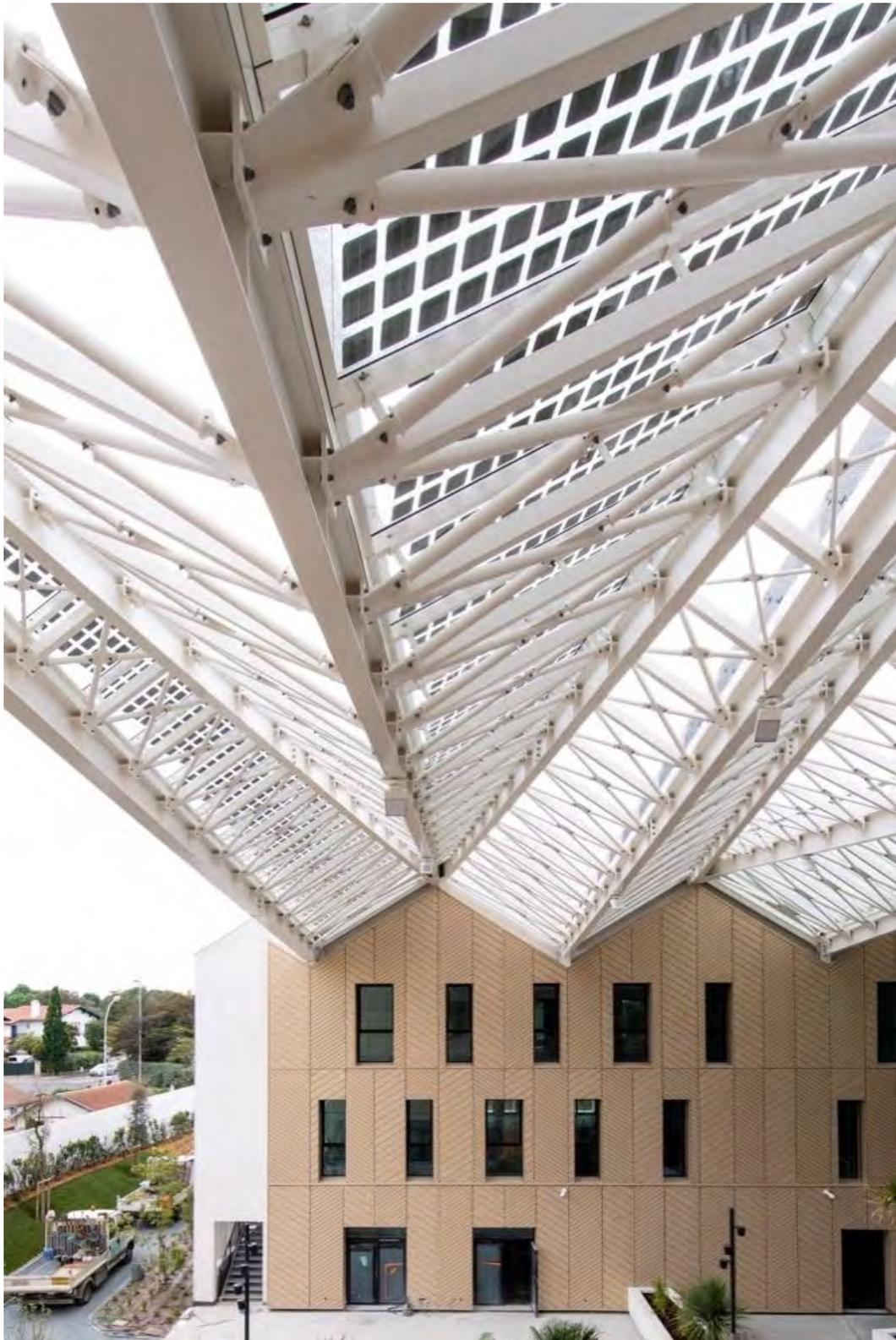
*Figure 3 : zoom sur la structure de la verrière avec sur les pans sud du vitrage photovoltaïque et côté nord un vitrage "classique".*
