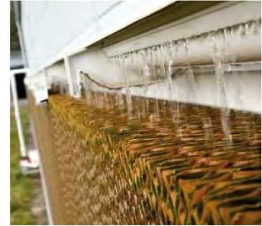
Figure 28 : panneaux de cellulose
