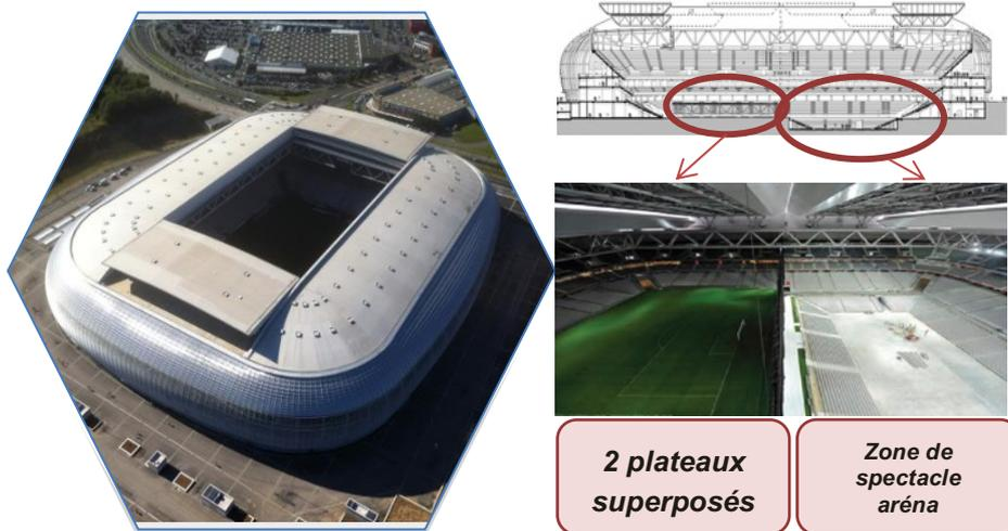
Le sujet s'intéresse au passage de stade à salle de spectacle qui débute par une étape de levage d'une demi-pelouse de 4500 tonnes par le biais de 12 vérins puis se poursuit par une étape de translation de ce plateau de façon à l'empiler sur l'autre demi-pelouse au moyen d'unités de translation à pas de pèlerin.
